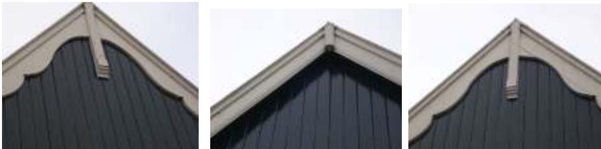
Detail topgevel 1 e serie huisnummers 33, 41 en 49 met overblijfselen van de gevelmakelaars.
