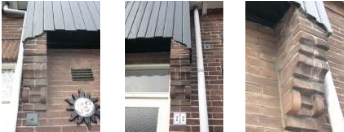
Detail: Bakstenen ornamenten onder houten topgevels van 2 e serie, huisnummer 22 en 28. Foto sep. 2013
