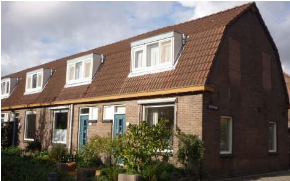
Wilhelminastraat 30-36. Gebouwd in 1930 door wbv 'Volkshuisvesting'.
