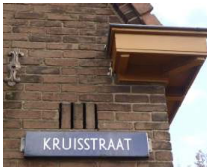
Detail woning Kruisstraat/hoek Wilhelminastraat. Foto oktober 2013.
