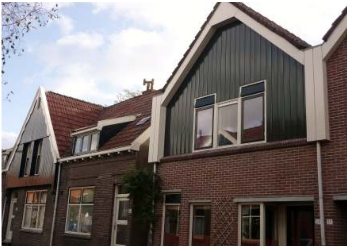
Zuiderkerkstraat. Links nr. 51 & 49, uit 1913. Rechts nr. 53 en 55 uit ca. 1980. Foto okt. 2013
