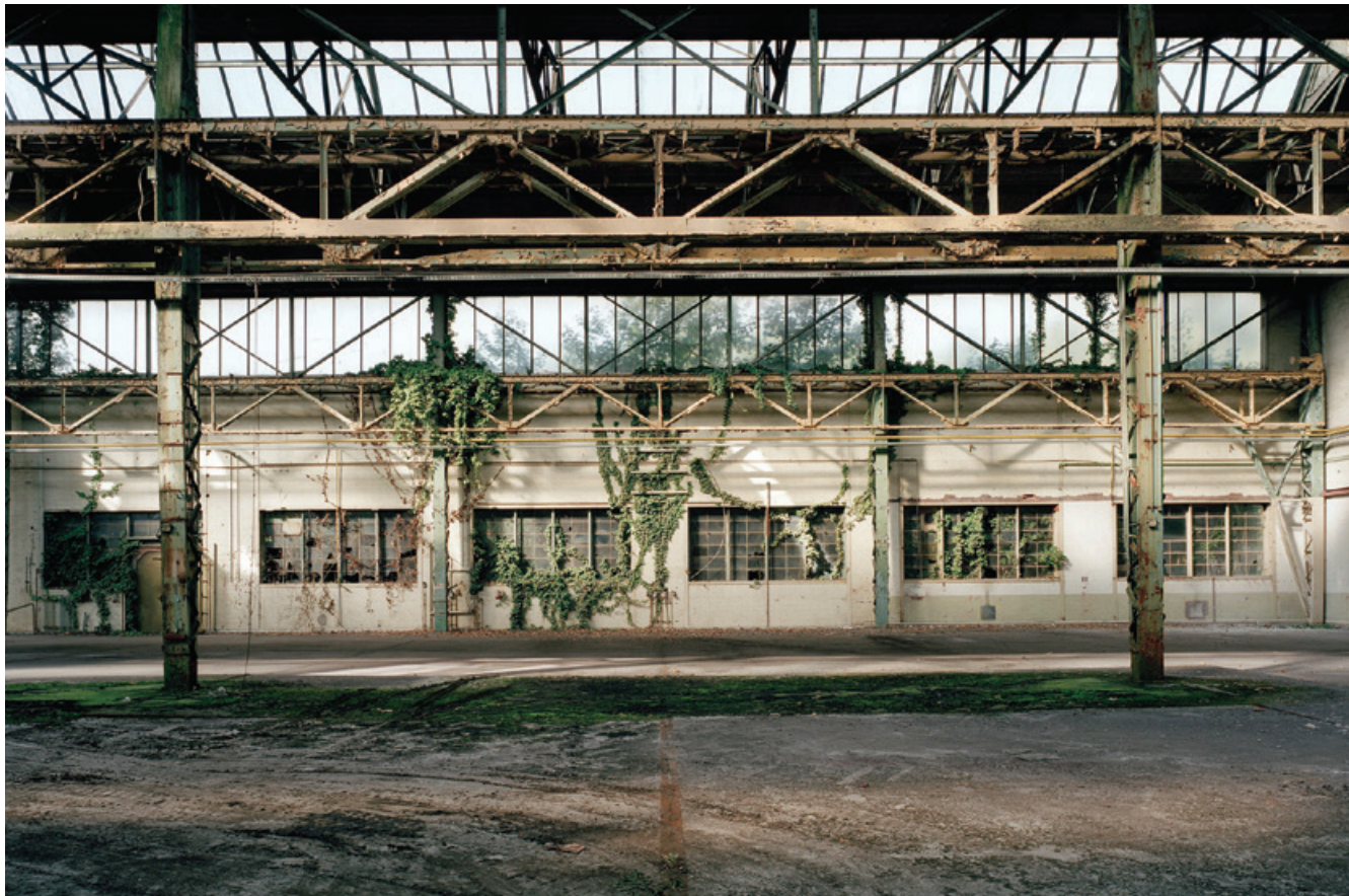
Gé Dubbelman, Affuitenwerkplaats op het Hembrugterrein (2003)
